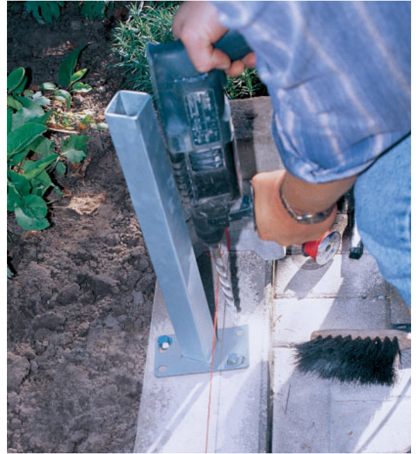
of met paalhouder vastschroeven.
